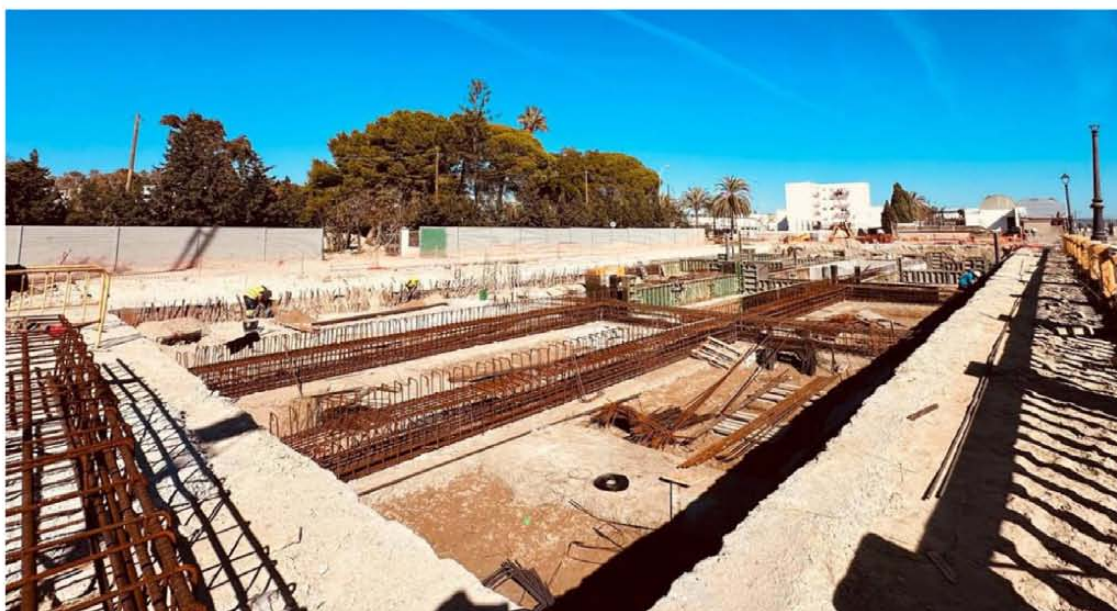
El tanque anticontaminación junto al río Guadalete.
