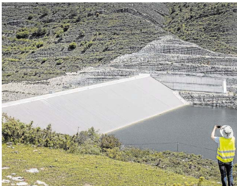
La presa de Terroba, el pasado mes de junio, sin haber entrado aún en funcionamiento. JUSTO RODRIGUEZ
